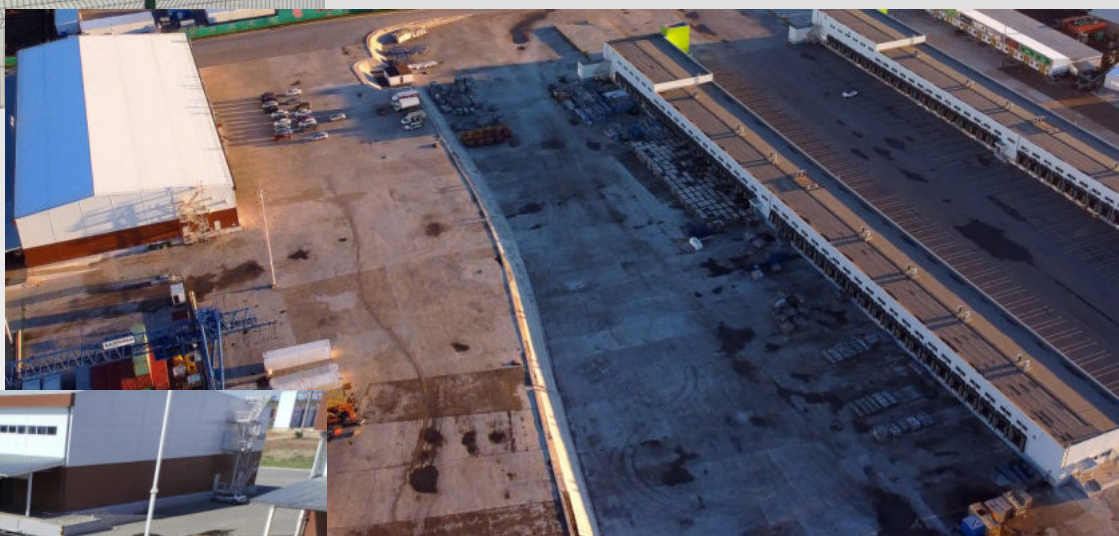
СКЛАД ВРЕМЕННОГО ХРАНЕНИЯ № 1 1500 м 2
